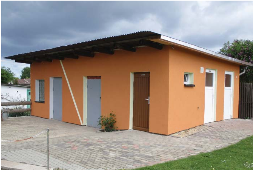
Der ehemalige Mehrzweckschuppen des KGV „Einheit“ Triptis ist nach seiner Kur kaum wiederzuerkennen – für die Kita-Kinder wurde eine zweite Toilette eingebaut. FOTOS: VEREIN
