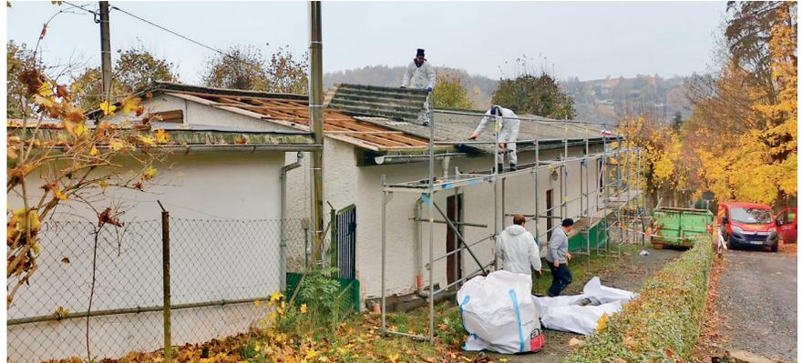
Im Jahre 2019 mussten Mitarbeiter einer Spezialfirma in Schutzanzügen das marode ge-wordene Asbestdach demontierten und in Big-Packs transportsicher verpacken.
