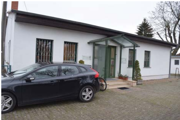
Seit über drei Jahrzehnten befand sich die LV-Geschäftsstelle und der Sitz des LV in der Erfurter Riethstraße.
