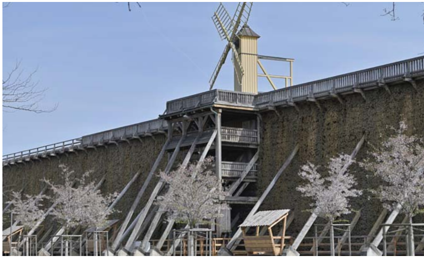
Das zwölf Meter hohe und 636 Meter lange Gradierwerk von Bad Dürrenberg ist das längste zusammenhängende derartige noch funktionierende Gradierwerk in ganz Europa.
